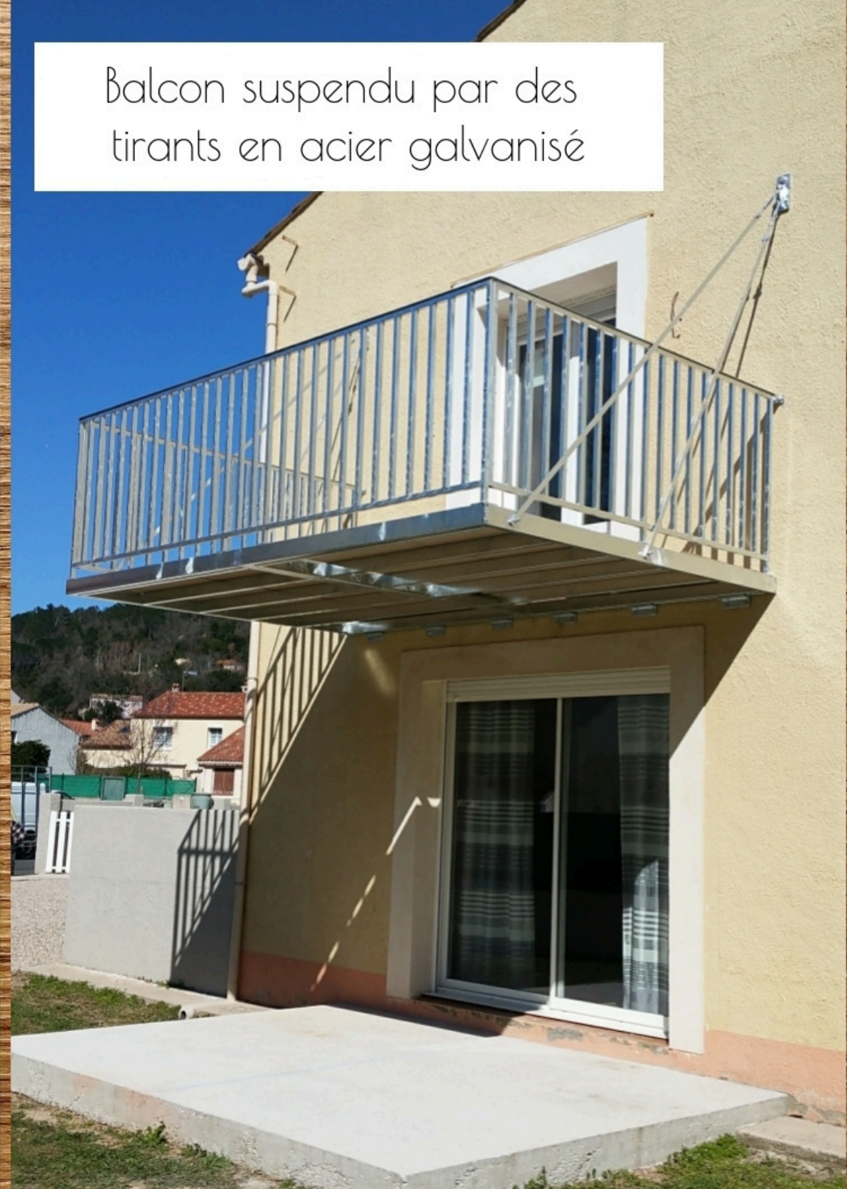
Balcon / Terrasse acier peint
